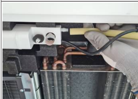
Afb. 21: Bevestig de condensaatlang aan de condensaatpomp
