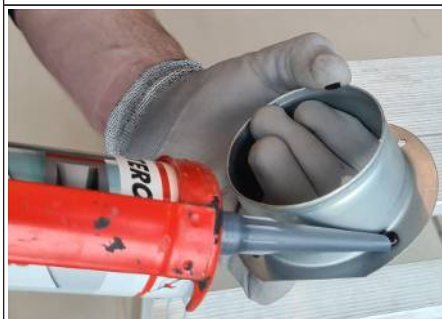
Afb. 24: De aanvoerluchtstomp afdichten
