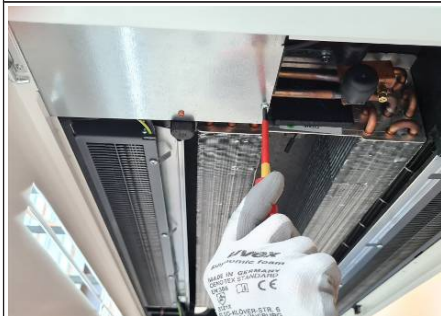
Afb. 20: Open de elektrische aansluitkast
