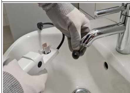
Afb. 46: Vuilfilter reinigen
