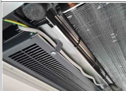
Afb. 19: De kabel van de servomotor leggen
