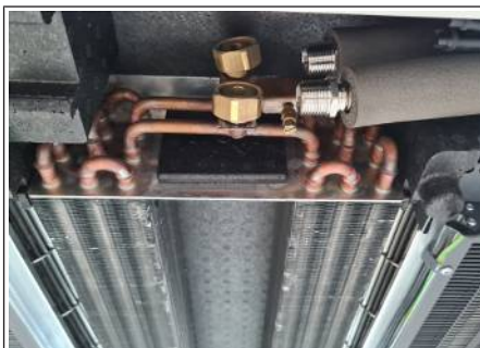
Afb. 18: Isolatie tot aan de schroefdraad
