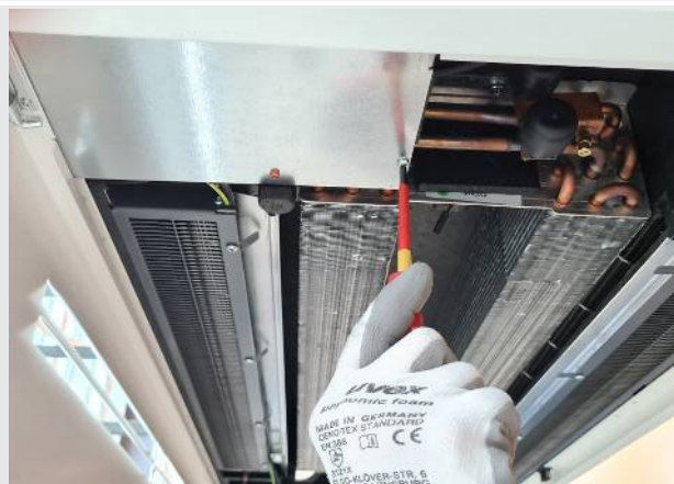
Open de elektrische aansluitkast met een kruiskopschroevendraaier en verwijder het deksel van de elektrische aansluitbox.
