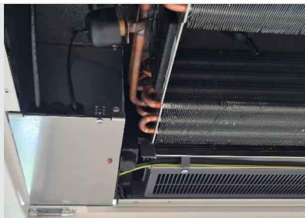
Positie van de elektrische aansluitbox (met verwijderde condensaatbak)
