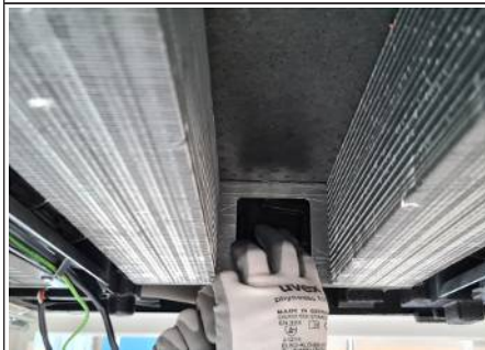
Afb. 25: Het aanvoerluchtdeksel verwijderen
